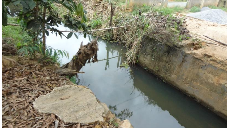
Figura 3-21– Trecho do Córrego São Pedro.
